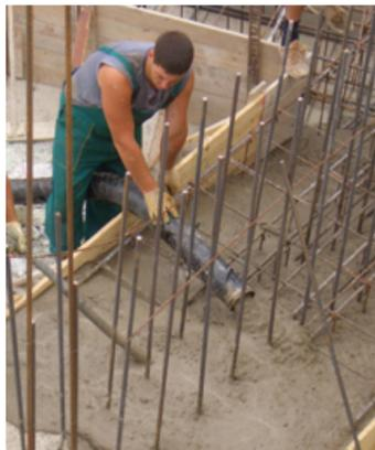
La P 718 refoule entre autres du béton fin jusqu'à une granulométrie de 32 mm.
